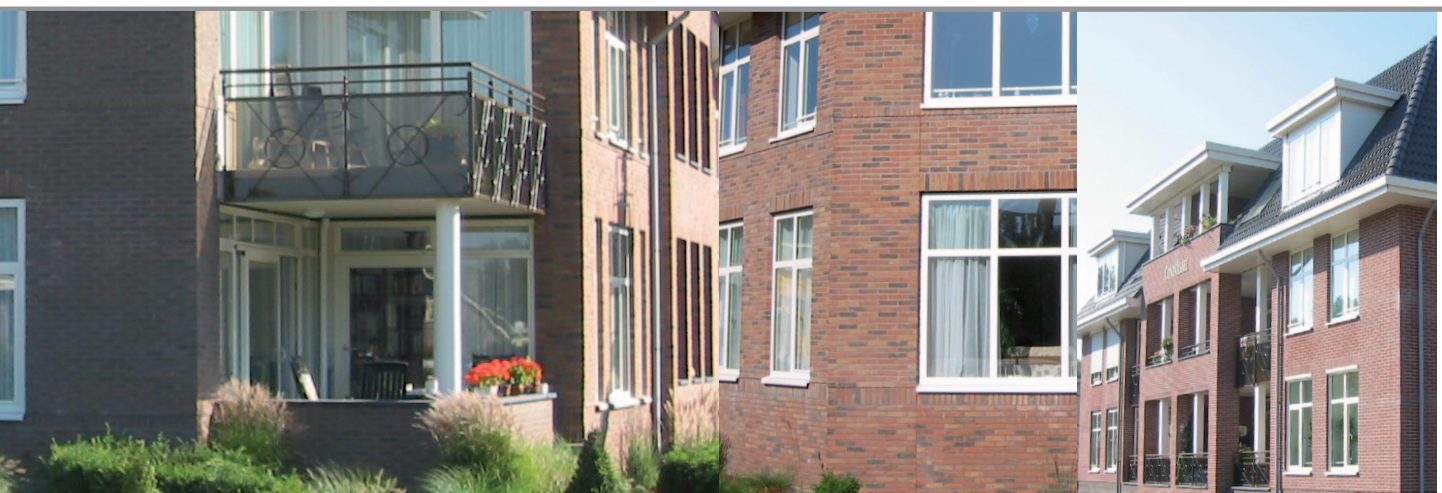
verspringing gevel met balkon
